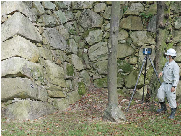
① 三次元レーザー測量 石垣表面の現状を把握
