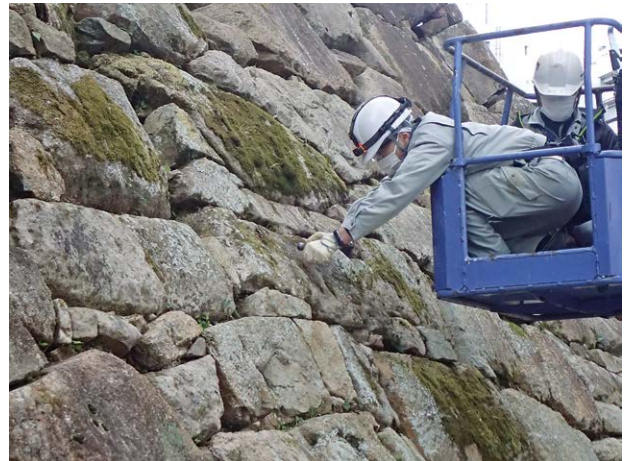
② 弾性波探査 表面の石の奥行を確認
