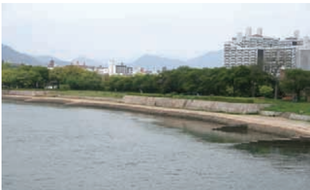
写真5 相生橋から見た本川東河岸
