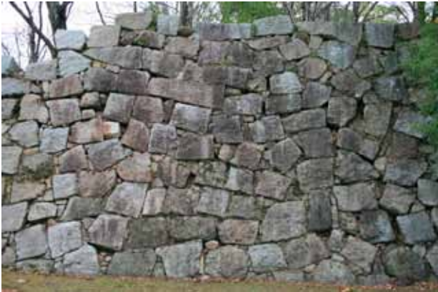
天守台から東に伸びる石垣の先端付近 打ち込みハギで築かれ、刻印が見られます。福島正則時代に築かれたとされます。
