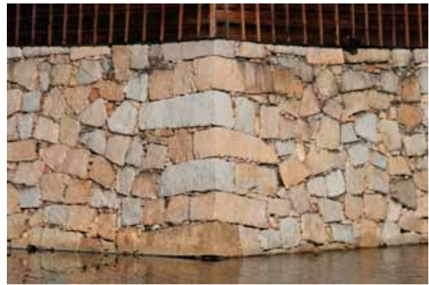
二の丸太鼓櫓石垣 隅が算木積みになっています。
