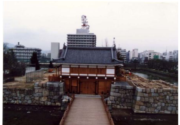
復元工事途中の二の丸
