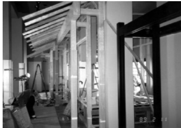
改装工事中の天守閣内(第二層 武家屋敷付近)
