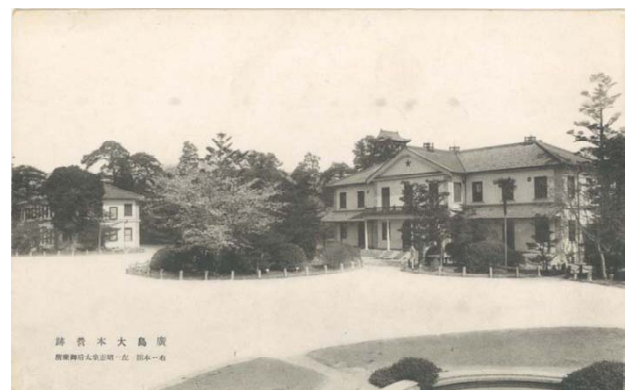
被爆前の広島大本営跡(右)と昭憲皇太后御座所(左)の建物 右の建物の後ろに天守閣が頭をのぞかせている
